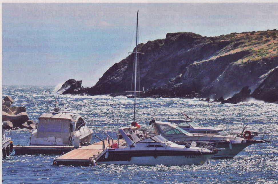
Le «T» en bout des pontons accueille voiliers et bateaux à moteur. La digue de 122 mètres, composée de 628 acropodes, les protège de la tramontane.
